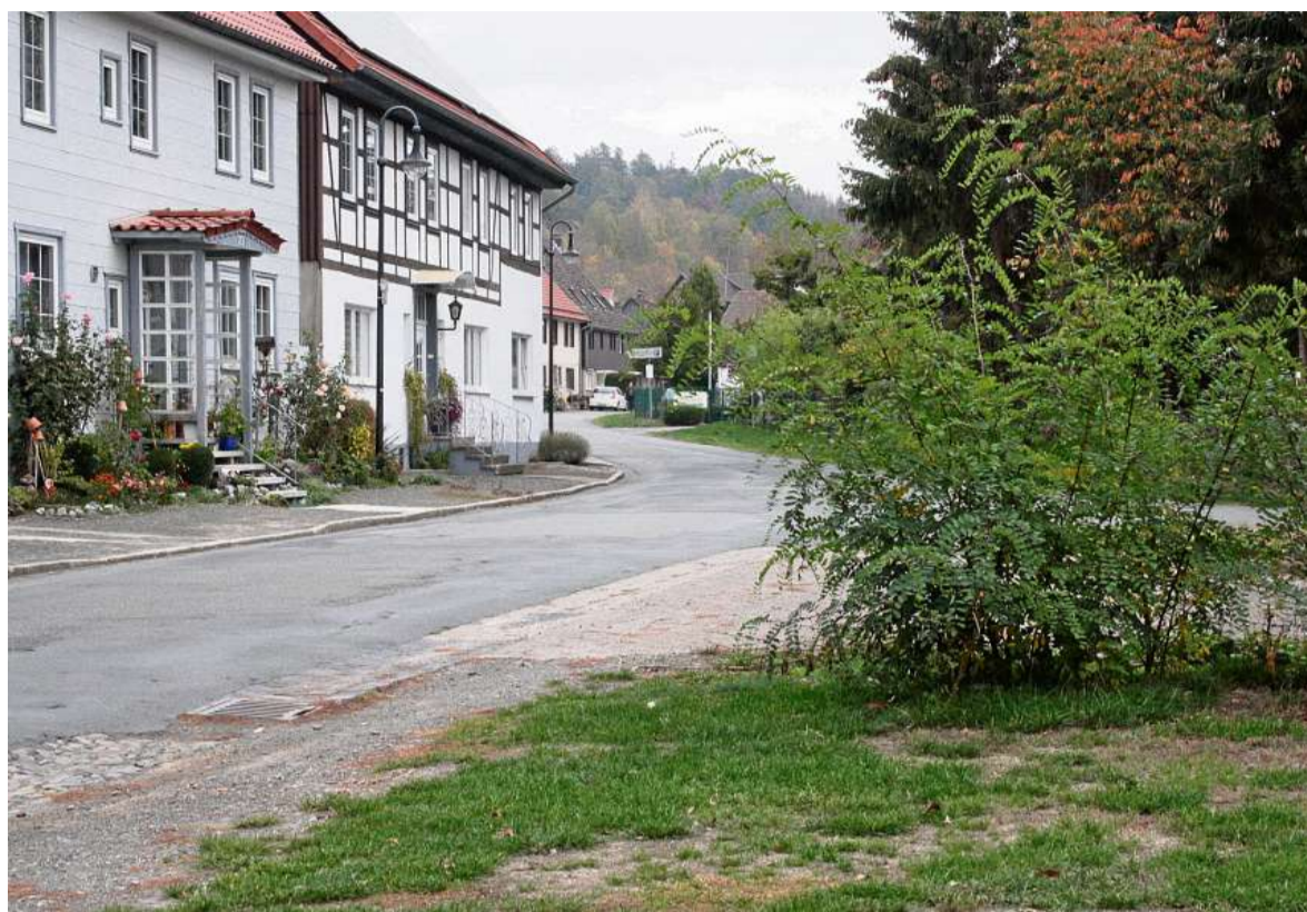
Die Hinterstraße in Scharzfeld soll im kommenden Jahr saniert werden. Die Stadt hat dafür einen Förderantrag im Rahmen der Dorfentwicklung gestellt.
